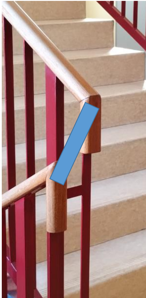
Garde-corps intérieur : Pièce de raccord pour continuité de la main courante
