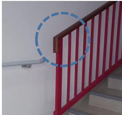
Garde-corps intérieur : Pièce de raccord pour continuité de la main courante
